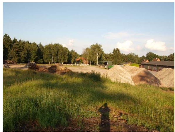
Östlicher Teil des Plangebietes mit Lagerflächen (Blick nach Osten)
