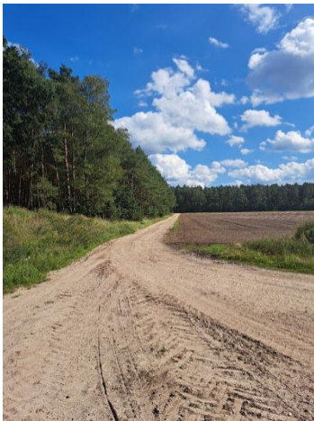
Abbildung 2: Zufahrt zur Biogasanlage / Wall und Wirtschaftsweg östliche des Geltungsbereichs
