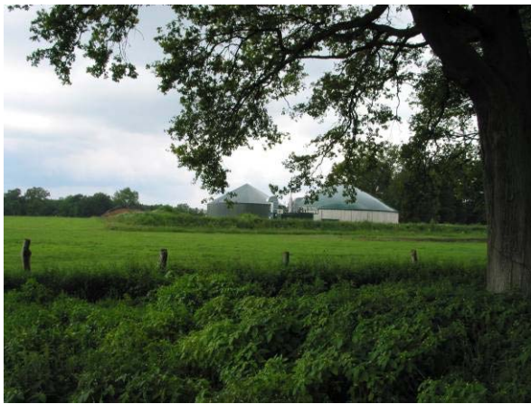
Blick von Südosten zur Biogasanlage
