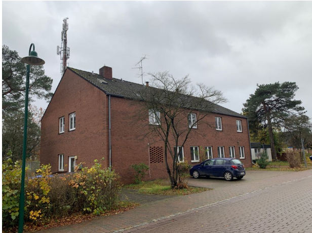
Abb. 2: Ehemalige Post (Hauptgebäude, Abb. 1, Nr. 1a)
